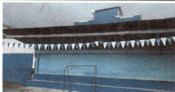
Foto 2: Sustrucción de lámina, por lámina troquelada aluzinc calibre 26, sustrucción de estructura de soporte de metal por metal
