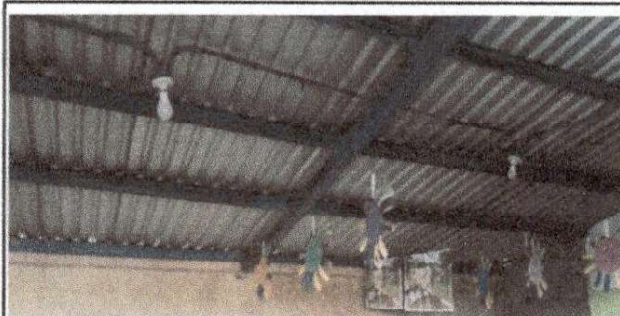
Foto 5: Reparación de sistema eléctrico
